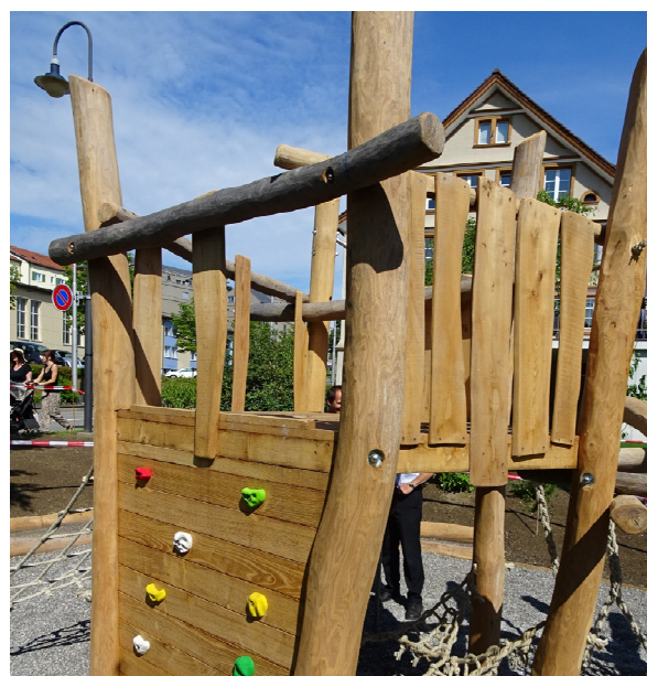
Illustration 9 Équipement de jeux avec garde-corps et balustrade
