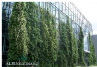
1 façade de Alpine Finanz, Glattbrugg
