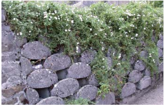
mur en éléments préfabriqués en béton
