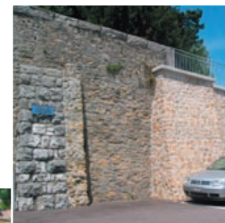
mur de soutènement
