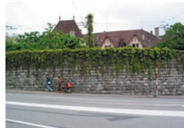
mur d'enceinte de propriété constitué de pierres de tailles identiques jointoyées grossièrement
