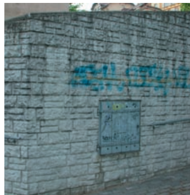
mur constitué d'éléments préfabriqués en béton dont les éléments de couverture sont arrasés
