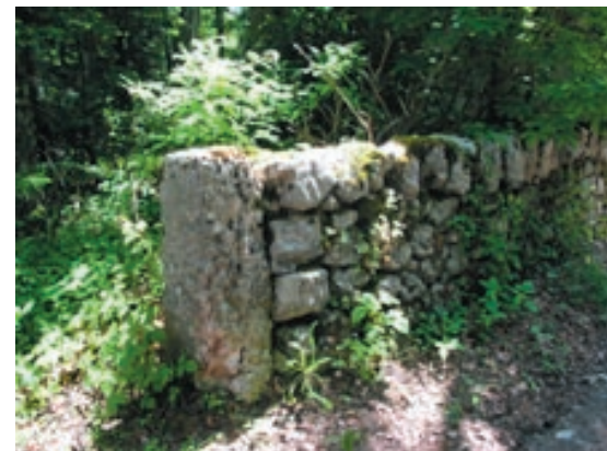
mur de limite de propriété
