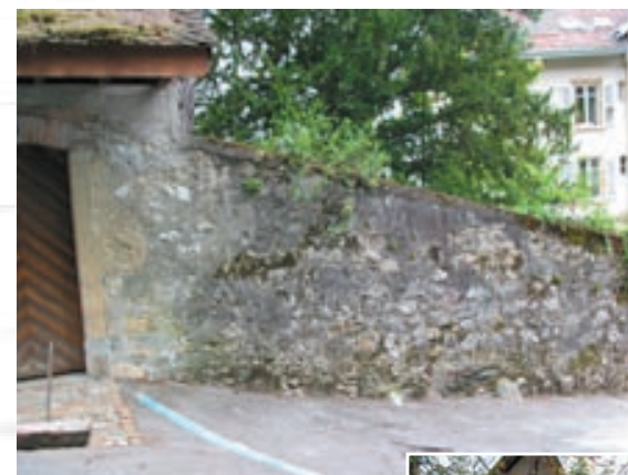
ancien mur de vigne où les interstices entre les pierres sont régulièrement rempochés*
