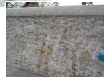
ancien mur de vigne restauré reprenant le principe des murs de vigne, avec un couvrement en arrondi
