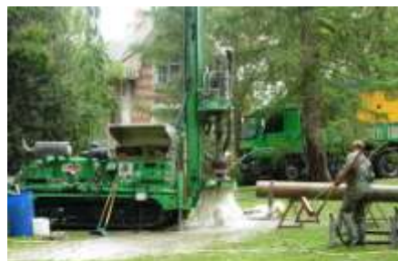
Forage en septembre 2010
