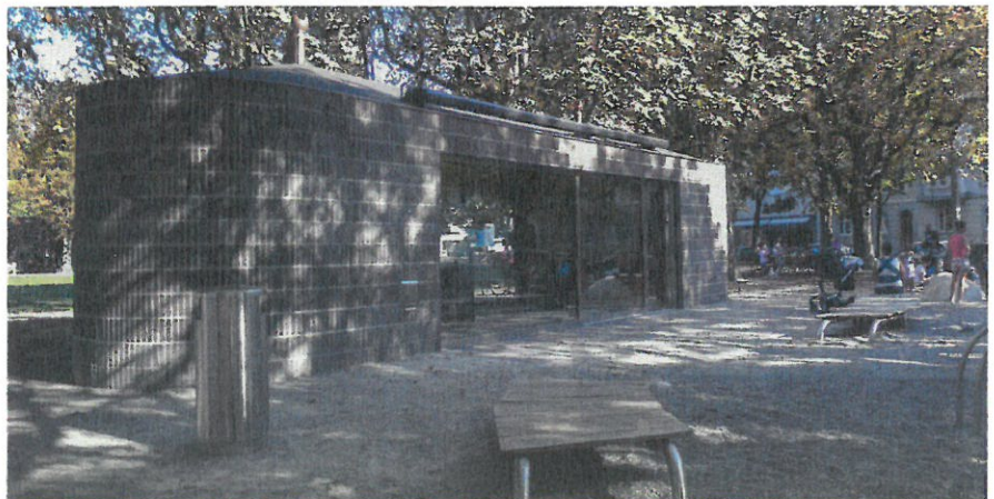
Das neue Infrastrukturgebäude des Basler Architekten Caesar Zumthor mit «Kindertankstelle» und einer öffentlichen WC-Anlage.
