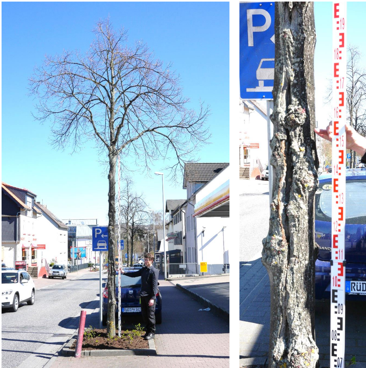
Abb. 39: Wiesbadener Straße in Idstein, Totale und typischer Schaden im Detail, Blickrichtung Osten Foto: C. Schreiber, 27.03.2017
