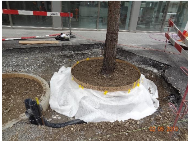
02.09.2019: Versetzter Baum inkl. Entlüftung
