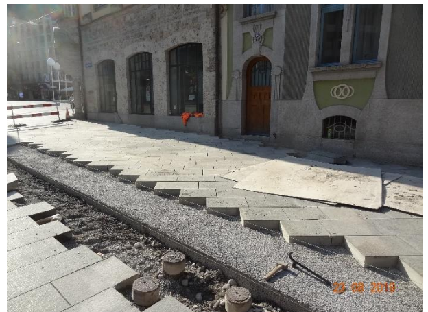
23.08.2019: Betoneinbau als Untergrund für Führungsplatten
