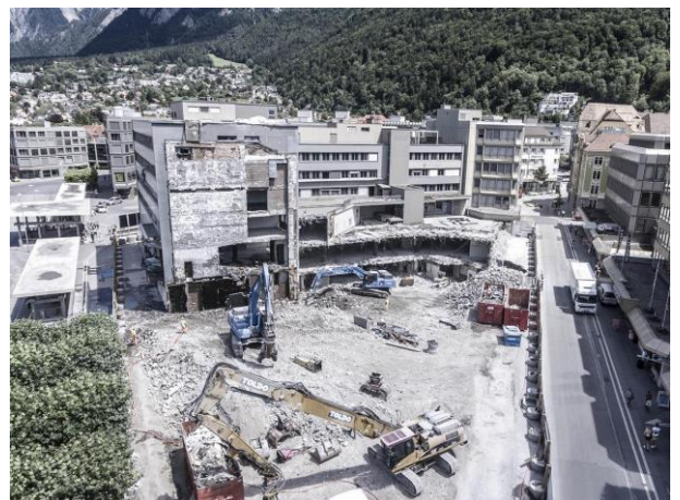
Abbrucharbeiten Globusgebäude zur Zeit der Gründung der internen Projektgruppe Steinbockstrasse
