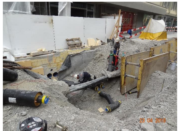
23.04.2019: Vorbereitungen Fernwärmeanschluss
