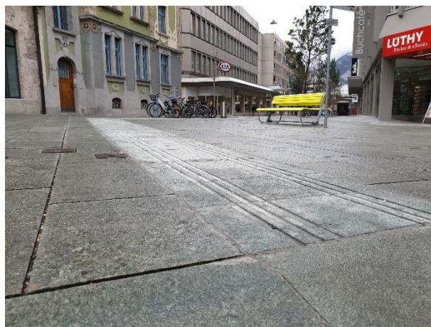
Führungsplatten für Sehbehinderte aus Granit, Übergang zur Wasserschale an der Bahnhofstrasse
