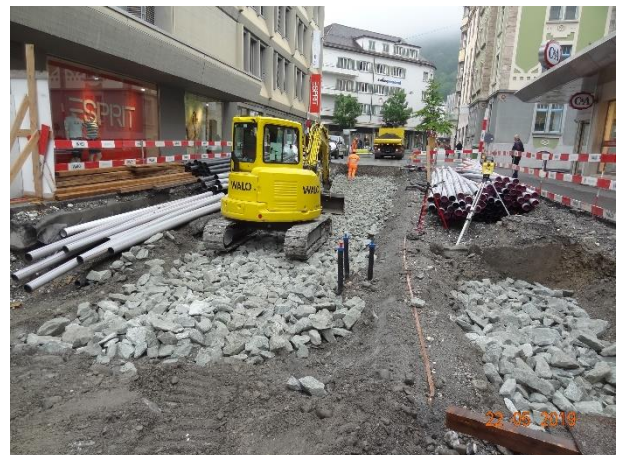
22.05.2019: Einbau Anderer Granit unter Baumgruben als Ergänzung zum Baumsubstrat
