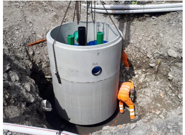
03.05.2019: Versetzen Mineralölabscheider
