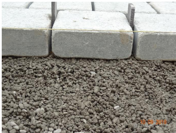
10.09.2019: Sickerfähiger Untergrund Pflasterung
