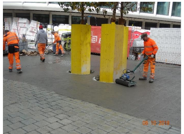
20.09.2019: Ausfugen Pflasterung mit sickerfähigem Fugenmaterial
