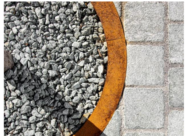
Stahlbandabschluss Baumgrube
