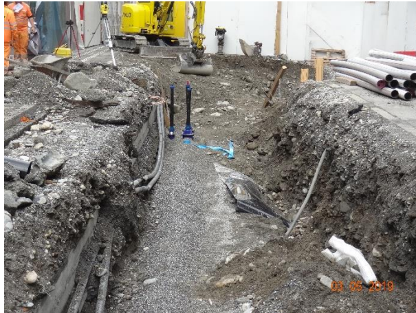
03.05.2019: Eingesandete Wasserleitung
