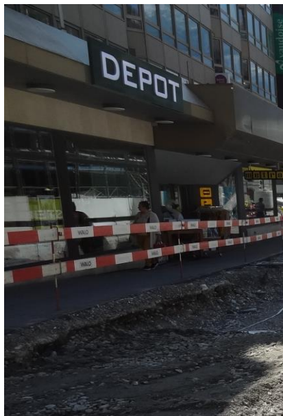
Fussgängerführung entlang der Baustelle und der Geschäfte
