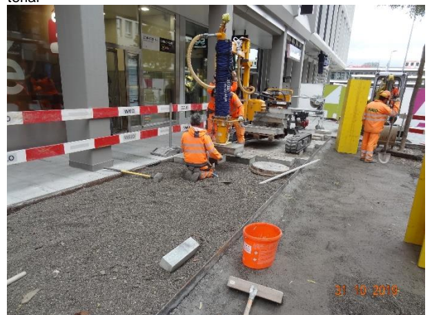
31.10.2019: Erstellung Bauminsel Bahnhofstrasse
