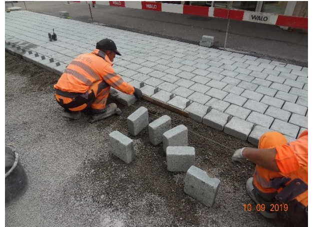
10.09.2019: Einbau Pflasterung mit Andeerer Granit
