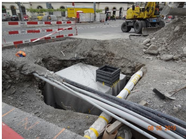
08.05.2019: Einbau Versickerungsanlage
