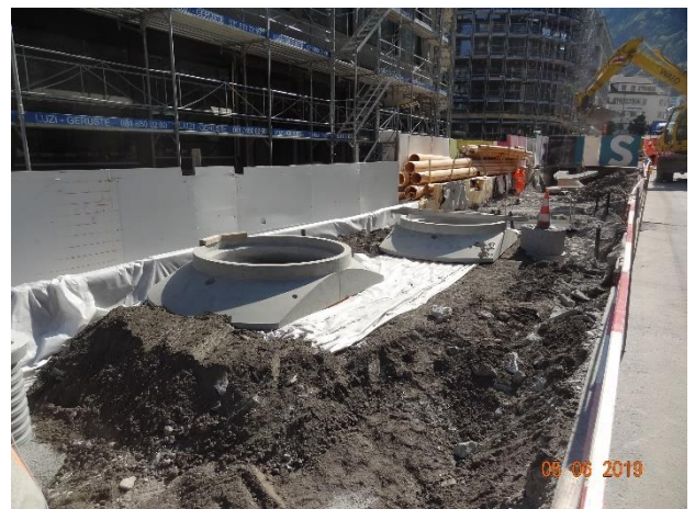
Spezielle Baumgrubenabdeckung
