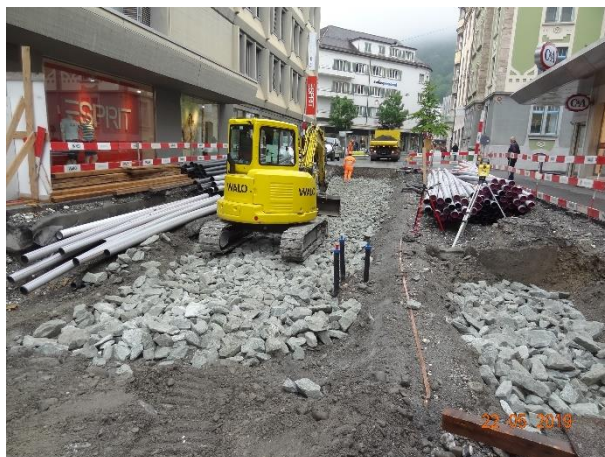
Grossflächige Packung mit Granitschroppen
