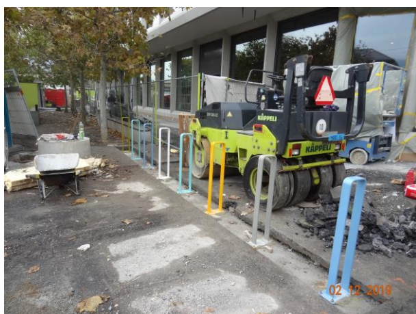
Einbau Anlehnbügel
