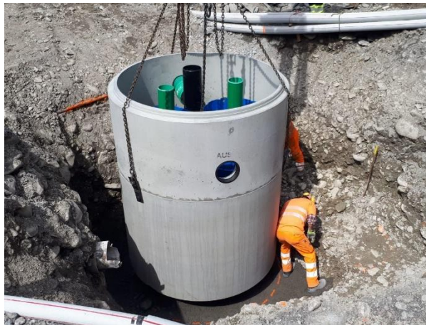
Vorgeschalteter Mineralölabscheider
