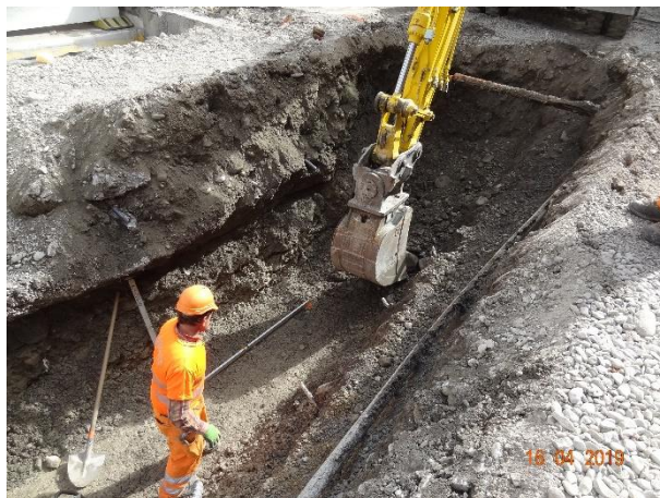
16.04.2019: Aushub Kanalisationsgraben
