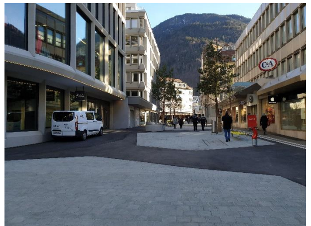
Nachher: Mitte Steinbockstrasse Richtung Bahnhofstrasse
