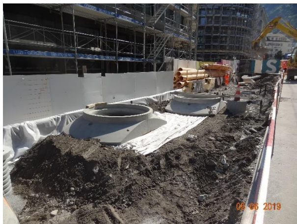
05.06.2019: Versetzen Baumgruben
