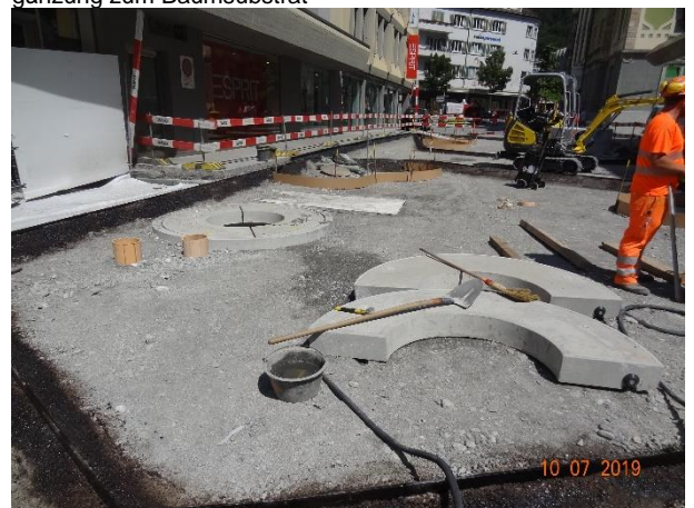
10.07.2019: Einbau Stahlbandabschluss und Baumgrubenabdeckung
