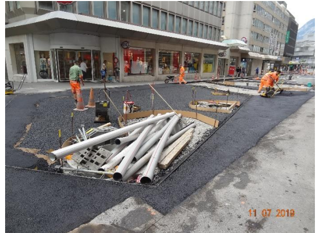
11.07.2019: Einbau provisorischer Belag
