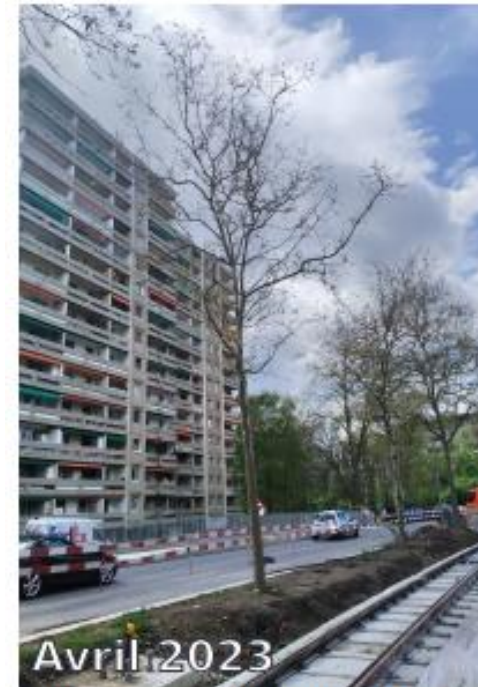
Platane en alignement le long du tram. Potentiel impact des travaux du tram à proximité.
