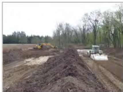
Travail du sol sur les zones de faible portance et redéploiement de la couche arable, avril 2012
