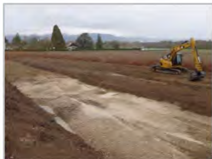
Travail du sol sur les zones de faible portance et redéploiement de la couche arable, avril 2012
