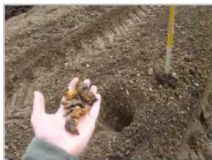
Broyage des rhizomes à la stabilisatrice et sondages ponctuels de contrôle, avril 2012
