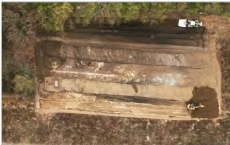
Décapage et stockage latéral de la couche arable broyée en 3 andains alternés, broyage de la sous couche à la stabilisatrice WIRTGEN WS 250 puis redéploiement de la couche arable, avril 2012
