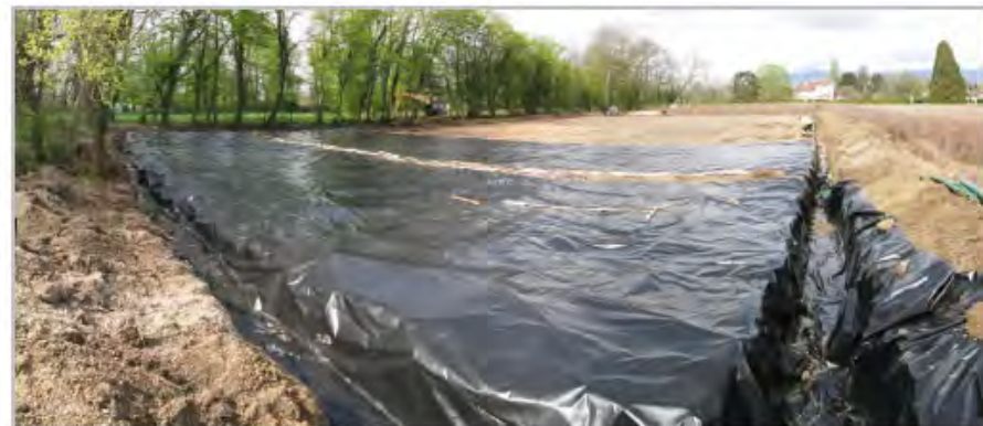
Creusement des tranchées d'ancrage périphériques et mise en place des 8 bandes de bâche, mi-avril 2012
