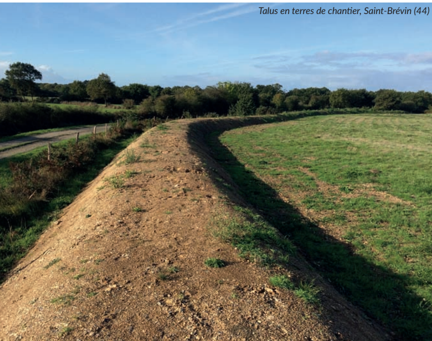
Talus en terres de chantier, Saint-Brévin (44)
