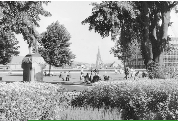
«Grosse Schanze» um 1964 in Bern: Die Begrünung der Parkterrasse und des Parkhauses war eine landschaftsarchitektonische Pioniertat in Europa.
