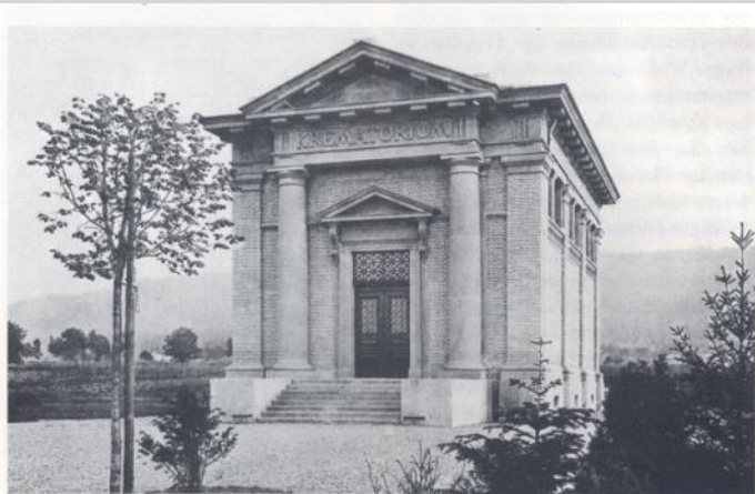
Das erste Krematorium, erbaut 1889 von Stadtbaumeister Arnold Geiser. Aufnahme 1889
